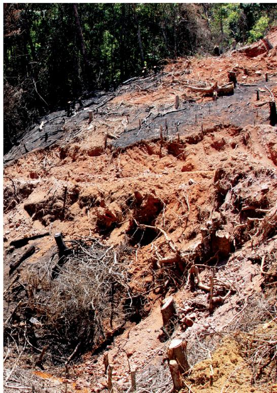
Perda de serviço ecossistêmico e processos geohidrológicos decorrentes, de erosão e assoreamento de curso d'água. Implantação do Rodoanel Norte na Região de Guarulhos, com desmatamento, corte e aterro. Foto: Antonio Manoel dos Santos Oliveira, 2014
